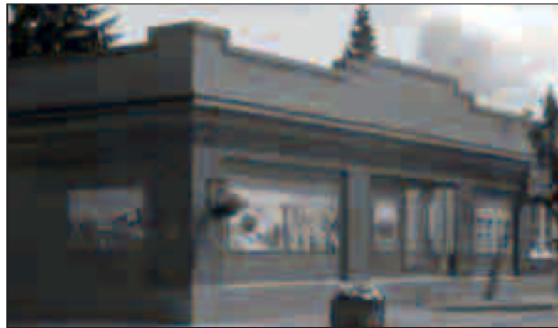
A. Parapet Wall
